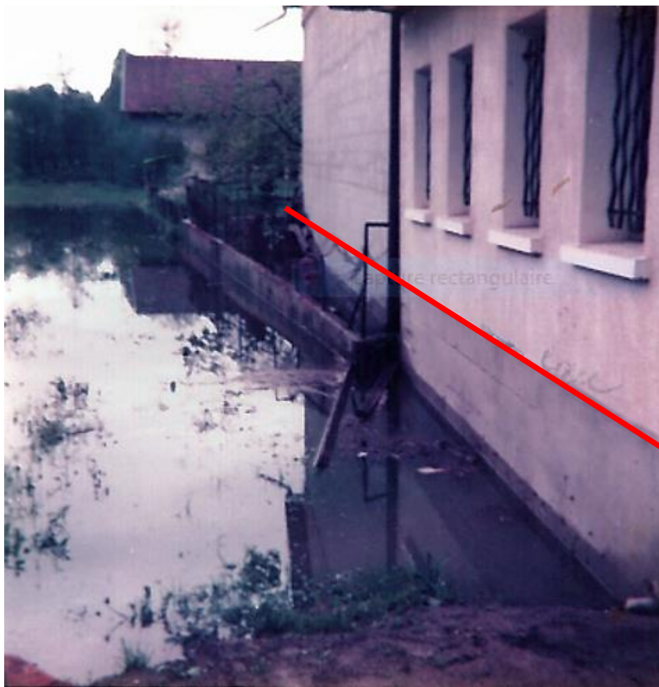
Inondation du secteur de la Pallud et de la zone humide avant le remblaiement de 1983 La trace visible sur le mur permet d'évaluer une hauteur d'eau de 70 cm environ.
