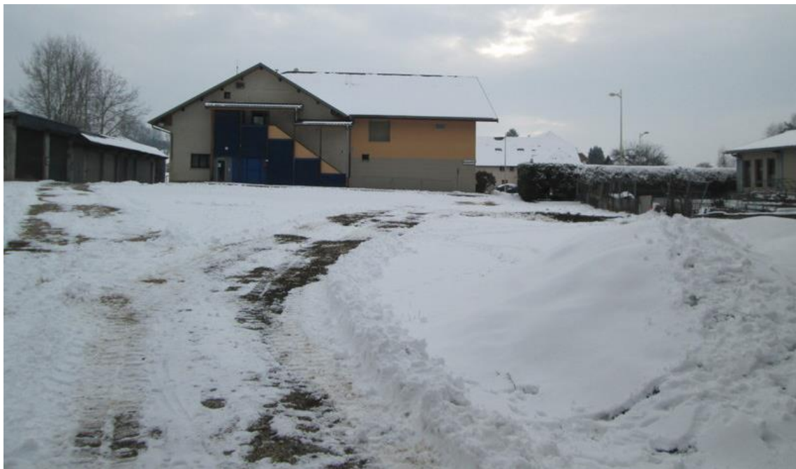
Photographie 7 : plateforme gravillonnée
