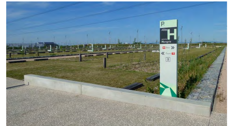
Figure 8. Exemple de réalisation de parking en mélange terre-pierre non-revêtu
