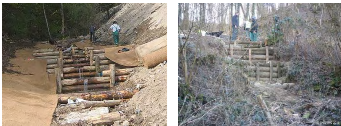
Figure 5. Exemples de mises en œuvre de seuils bois (Garon ou Yzeron)
