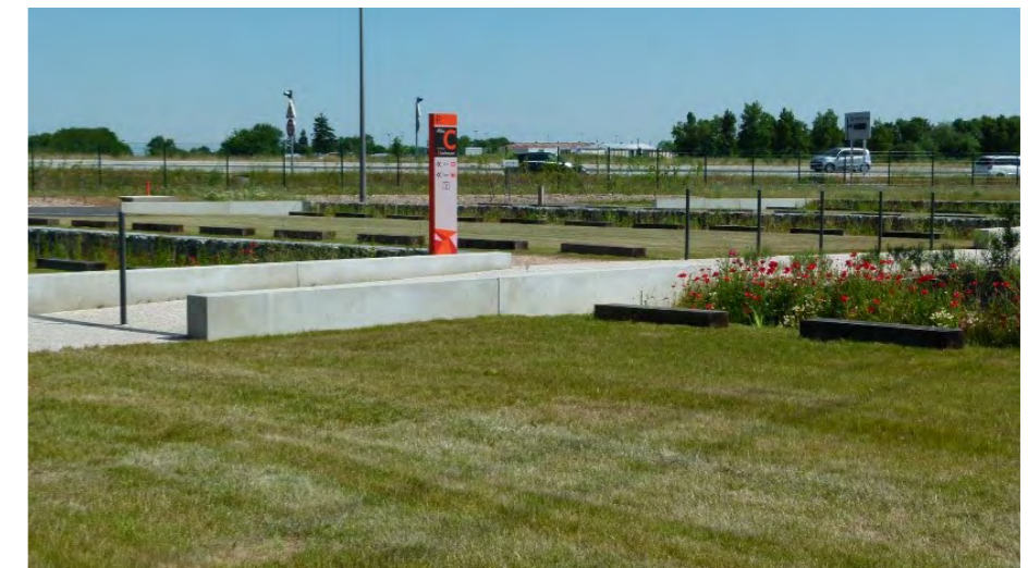
Figure 9. Exemple de réalisation de parking en mélange terre-pierre engazonné
